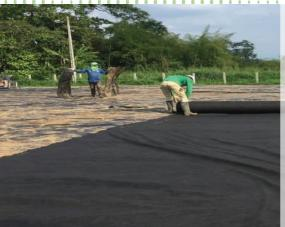
Los geotextiles no tejidos son fabricados con fibras de polipropileno, con altos estandares de calidad. Es resistente a la degradacion por efectos de rayos UV, a la humedad, a agentes quimicos, minerales biologicos normalmente encontrados en la tierra. Estos productos no deben ser incinerados por que no son biodegradables.
