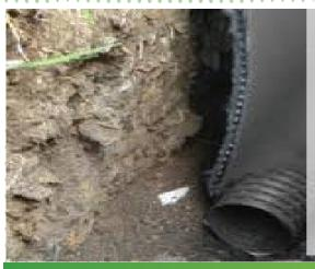
Geotuberia, es una tubería para drenaje en polietileno de alta densidad, de forma corrugada con orificios en todo su perímetro, para captar los excesos de agua libre en el suelo.
