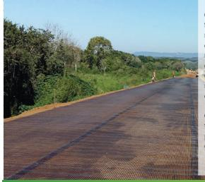
Geomallas Biaxiales, están fabricadas en PET y sus fibras cuentan con un copolímero otorgando rigidez dimensional, la combinación estratégica de sus componentes avanzados, generan alta resistencia a la tensión y alta flexibilidad a las estructuras a cubrir, sin afectar su estructura gracias a su estabilidad en el comportamiento mecánico a largo plazo a través de su baja plasto deformación.
