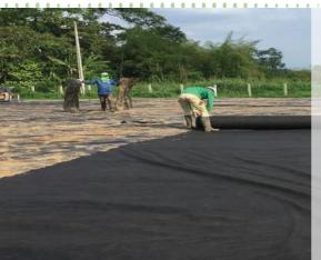
Los geotextilestejidos son fabricados con fibras de polipropileno, con altos estandares de calidad. Es resistente a la degradacion por efectos de rayos UV, a la humedad, a agentes quimicos, minerales biologicos normalmente encontrados en la tierra. Estos productos no deben ser incinerados por que no son biodegradables.
