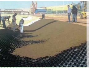
Geocelda, es un sistema laminado tipo panel, de polietileno de alta densidad, con unión de ultrasonido, utilizadas para refuerzos de suelos, en cimentación, pavimentos y canales. Geocelda es un sistema liviano, expandible, durable, adaptable a los diferentes tamaños y según necesidad.
