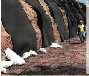
Geodren es un sistema de geocompuestos, conformado por un sistema de drenaje de geored, de HDPE y geotextil no tejido como filtrante. La geo red genera alta resistencia a la presión manteniendo su espesor bajo altas cargas, el geotextil por su parte permite el paso eficiente del agua, conservando su geometría y tamaño de abertura de poros bajo condiciones de tensión y confinamiento.
